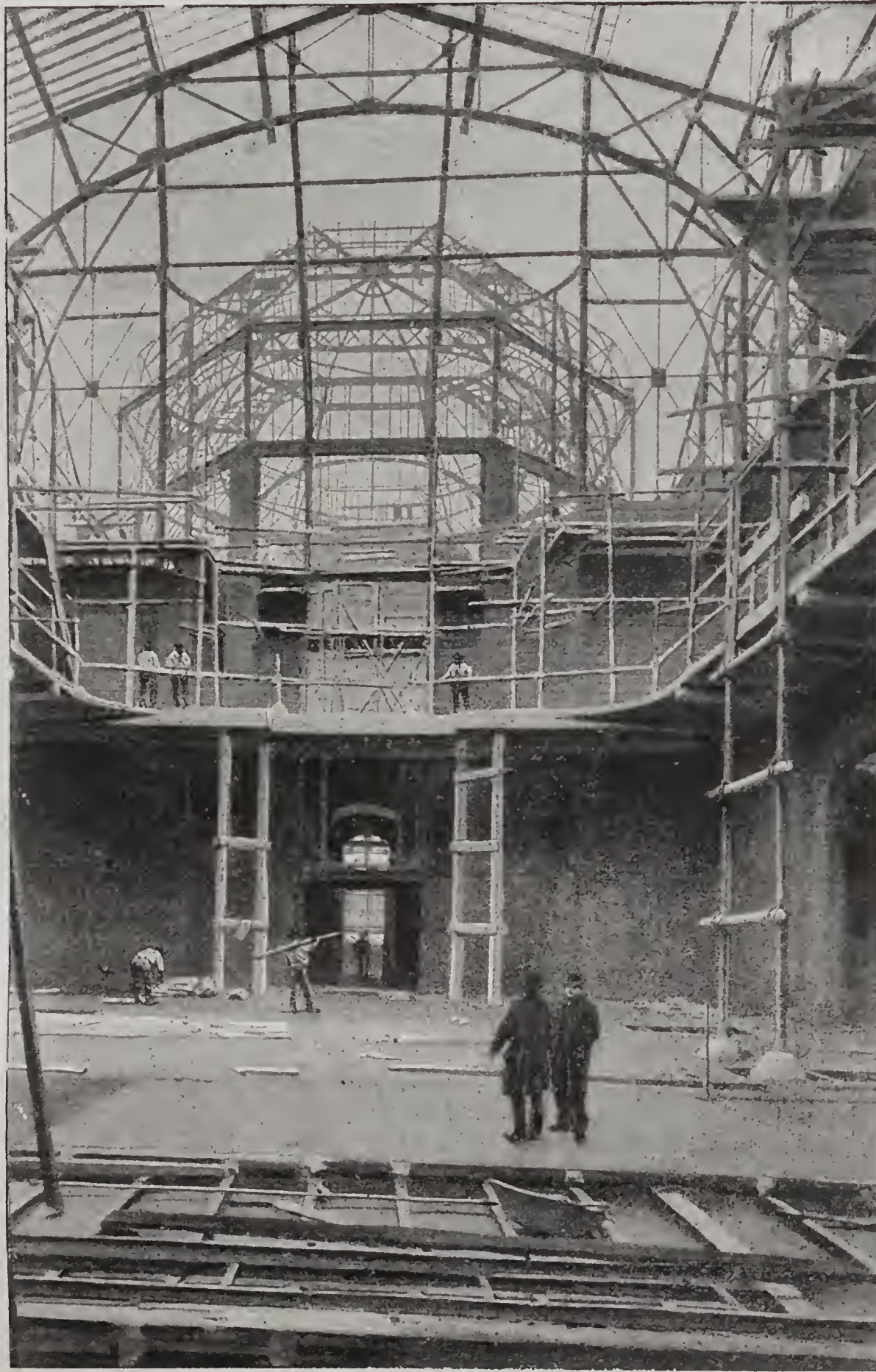
LES CHARPENTES EN FER. — Ossature du dôme à l'angle de la façade sud. (Grand Palais.)
